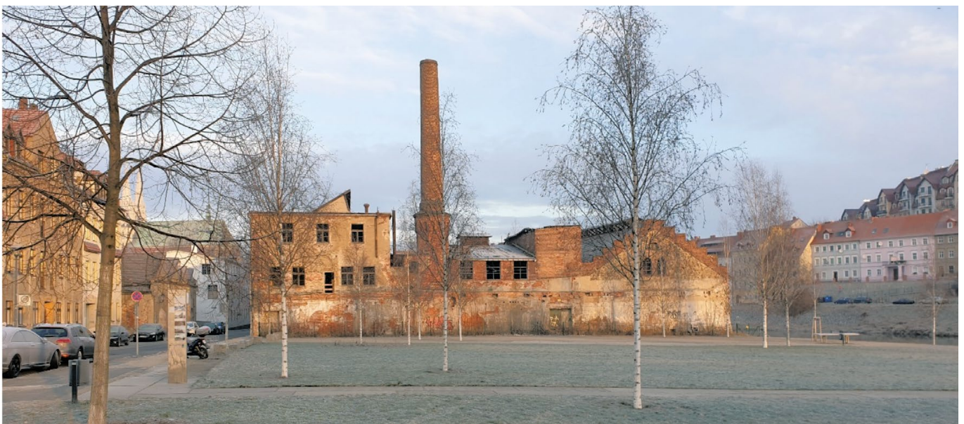
Abb. 1: Leerstehendes altes Kondensatorenwerk am Görlitzer Neißeufer. Das Zentrum für datenintensive Systemforschung CASUS, das dort 2026 einziehen soll, wird mit Strukturförderungsmitteln im Rahmen des Kohleausstiegs unterstützt. (Foto: Bettina Knoop)
