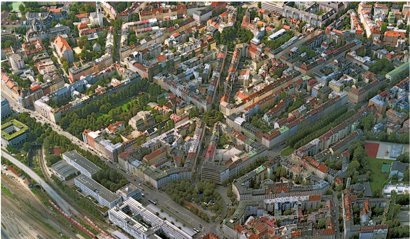
Abb. 2: Franzosenviertel in München, Dichte mit Städtebau: hohe bauliche und funktionale Dichte mit schönen öffentlichen Stadträumen – aber nach heutigen Vorschriften nicht mehr zu bauen (Foto: Hajo Dietz Nürnberg Luftbild)
