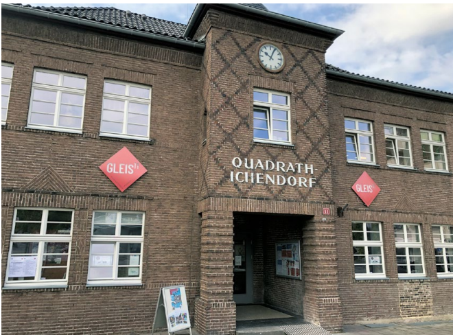
Abb.1: Das Gleis 11 in Bergheim-Quadrath-Ichendorf – das ehemalige Bahnhofsgebäude wurde über Mittel der Städtebauförderung zu einem Begegnungszentrum umgebaut (Quelle: © ILS)
