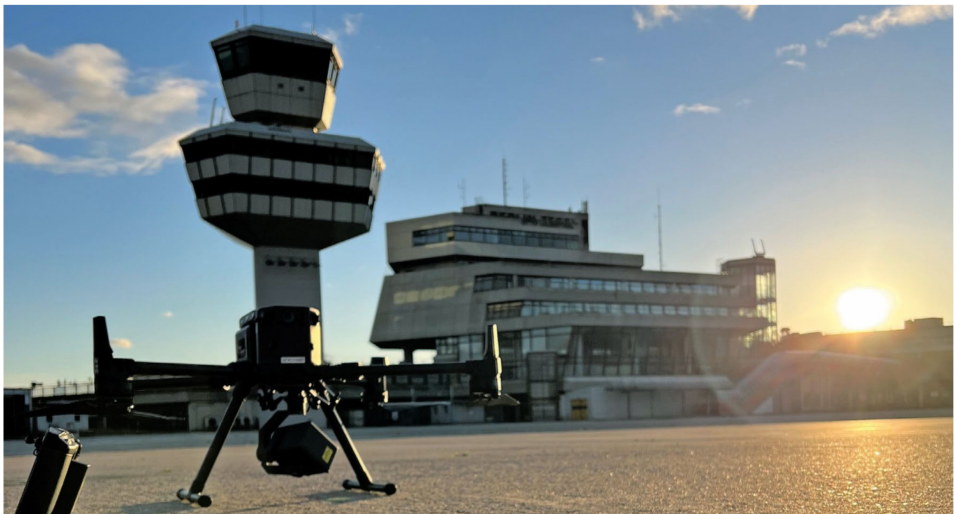
Abb. 1: Drohne auf dem Vorfeld des Towers (Fotos: Tegel Projekt GmbH)
