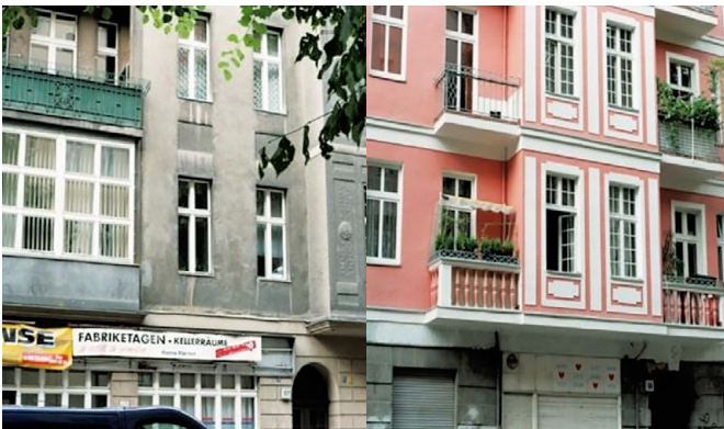
Abb. 1 und 2: Fassadensanierung als Zeichen von räumlicher Aufwertung im Quartier, Berlin-Neukölln (Quelle: eigene Aufnahmen)
