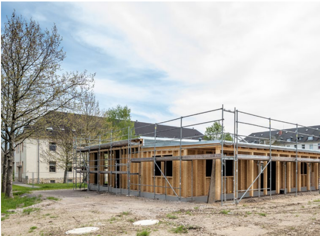
Abb. 5: Im Bau befindliches Werkhaus in Saalfeld-Beulwitz (© Thomas Müller, IBA Thüringen)
