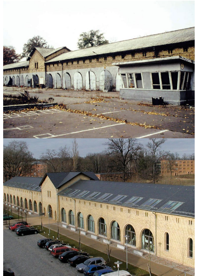
Abb. 1 und 2: Gebäude der Garde-Ulanen-Kaserne vorher und nachher (Quelle Abb. 1: FilmArt, Abb. 2: Frank Gaudlitz)
