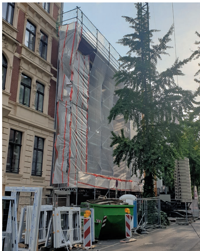
Abb. 1: In Innenstädten ist es schwer, modular zu bauen, um damit das Bauen zu beschleunigen. Oft fehlt der Platz, um vorgefertigte Bauteile anzuliefern und zusammensetzen. Es kann nur konventionell gebaut werden. (Fotos: Bernhard Hoffmann)
