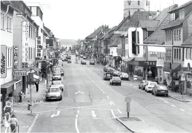
Abb. 1: Die Friedrichstraße in den 1980er Jahren als durchgehende Autostraße (Foto: Stadt Balingen)
