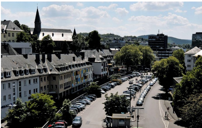
Abb. 5: Siegplatte (Parkplatz) vor Abriss. Links die kanalisierte Sieg (Quelle: https://www.polis-award.com/teilnehmer/siegen-zu-neuen-ufern-14-02-2018-1613/ ).
