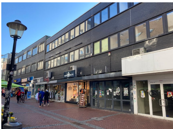
Abb. 2: Der in weiten Teilen leer stehende „schwarze Block“ bietet ungenutztes Aufwertungspotenzial für das Zentrum Gelsenkirchen-Buer (Foto: F. Steinbach)
