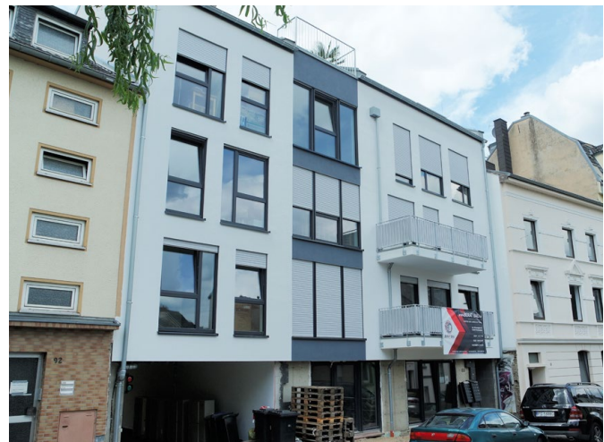
Abb. 1: Nachverdichtung im Bestand bietet Potenzial für neuen Wohnraum (Foto: F. Steinbach)
