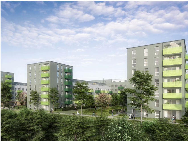
Abb. 1: Wohnungsneubau in Kelsterbach-Mainhöhe (Fotos: NHW)
