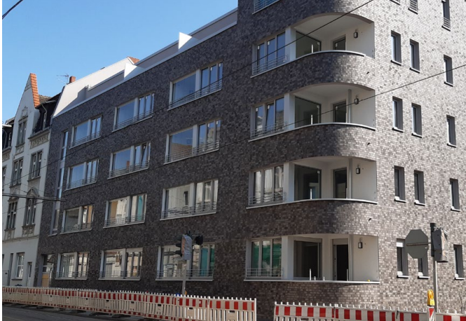
Abb. 1a und 1b: Stabilisierender Umbau Bochumer Straße in Gelsenkirchen-Ückendorf (Quelle: Bildrechte Institut für Stadtgeschichte, Stadt Gelsenkirchen, 2020/2022)
