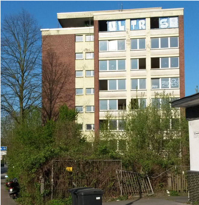
Abb. 6: Rückbaugebot Hochhaus Emil-Zimmermann-Allee/Horster Straße in Buer (Quelle: Referat Stadtplanung, 2019)
