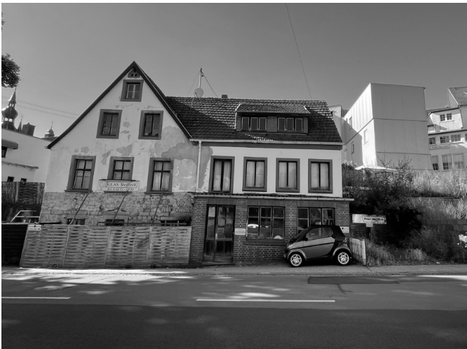
Abb. 1: Nicht mehr nutzbares Gebäude in einem zu verdichtenden Zusammenhang in St. Wendel (Foto: Dirk Löhr)
