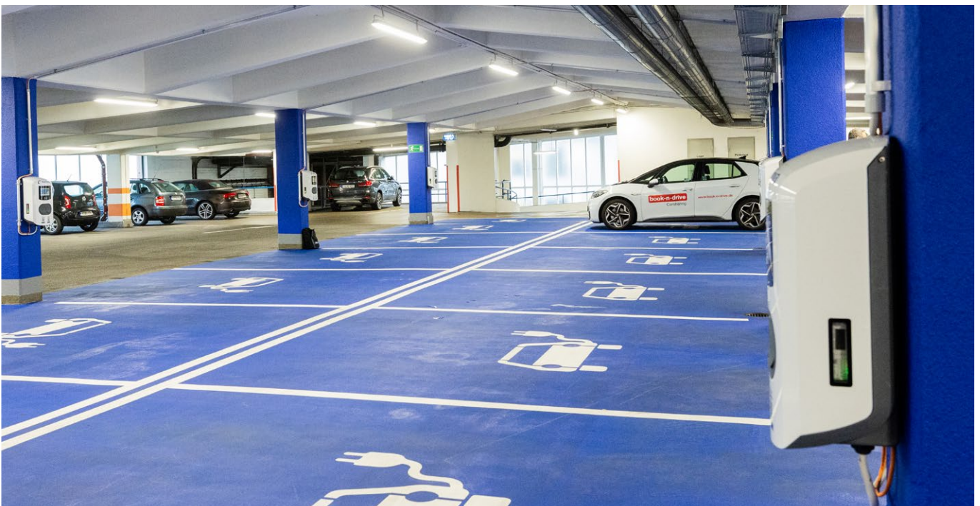
Abb. 1: Parkhaus Hauptwache in Frankfurt am Main (Foto: Mainova AG)
