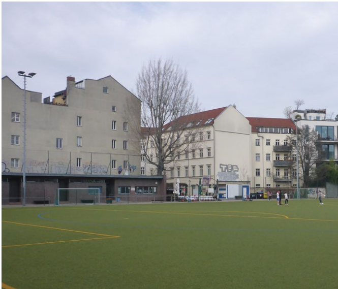
Abb. 4: Wohnbebauung an einem Großspielfeld
