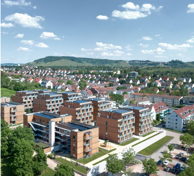
Abb. 3: Gebäudeensemble für Mitarbeitende des Klinikums Stuttgart mit 330 Wohneinheiten in Stuttgart. Errichtet in Holzmodulbauweise im EH-40-Standard. Bauherr: Stuttgarter Wohnungs- und Städtebaugesellschaft (SWSG), Herstellende/Planende: AH Aktiv-Haus GmbH mit WOLFF & MÜLLER Hoch und Industriebau GmbH & Co. KG mit Prof. Dr. D. E. h. Dr. h. c. Werner Sobek (Bildquelle: AH Aktiv-Haus GmbH/Tobias Vosseler)
