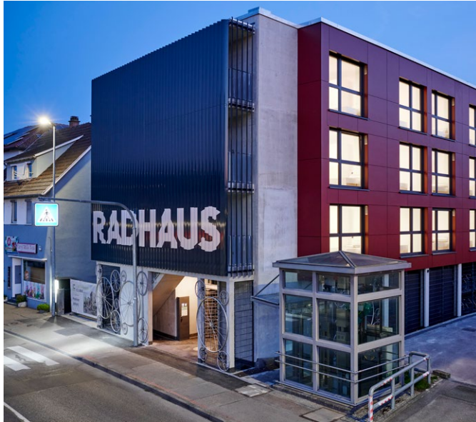
Abb. 2: Wohnheim für Berufsschüler und Auszubildende der nahe gelegenen Berufsschule mit 19 Wohneinheiten und einem öffentlichen Radhaus in Schorndorf. Errichtet in Holzmobulbauweise im EH-40-Standard und QNG-Zertifizierung. Bauherr: Kreisbaugesellschaft Waiblingen GmbH, Hersteller/Planende: Lechner Cube Holzmodulbau GmbH mit a+b Architekten (Bildquelle: Peter Oppenländer)
