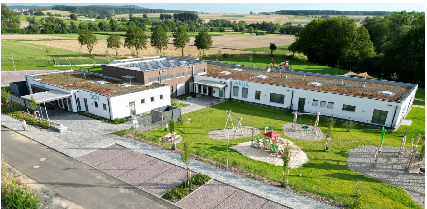
Abb. 1: Multifunktionsgebäude in Gudensberg (Foto: Christian Gerlach)
