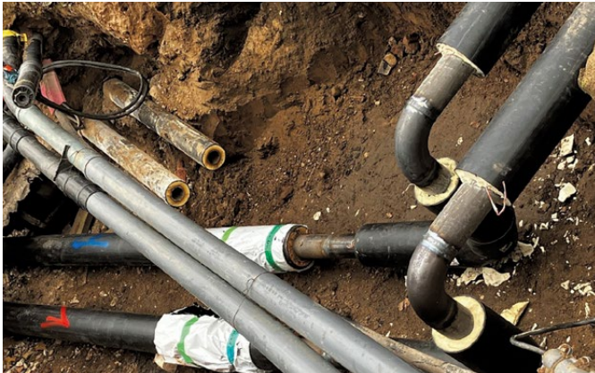
Abb. 3: Baustelle für die Fernwärme (Foto: Till Jenssen)
