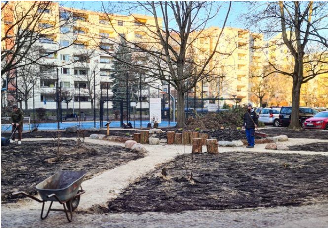
Abb. 6: Fertiggestelltes Trittsteinbiotop im Dezember 2025 (© Dominik Jentzsch)
