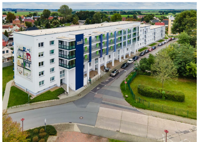
Abb. 6: In Nünchritz wurde ein Fünfgeschoss abgetreppt und barrierefrei umgebaut (© non malus gmbh)
