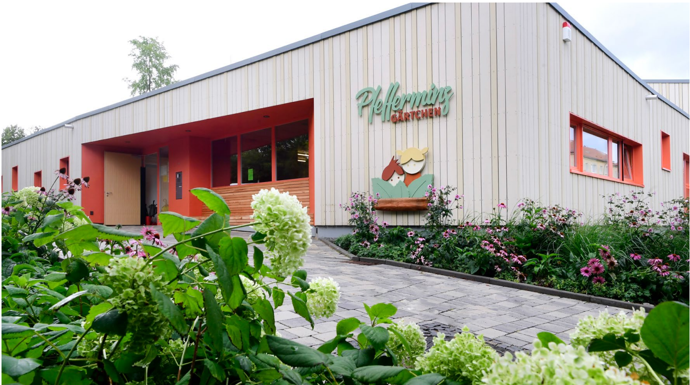
Abb. 7: Kölledas kommunale Wohnungsbaugesellschaft hat mit dem Bau einer innovativen Kindertagesstätte in Holzbauweise Verantwortung für die Kinderbetreuung übernommen (Foto: Barbara Neumann)
