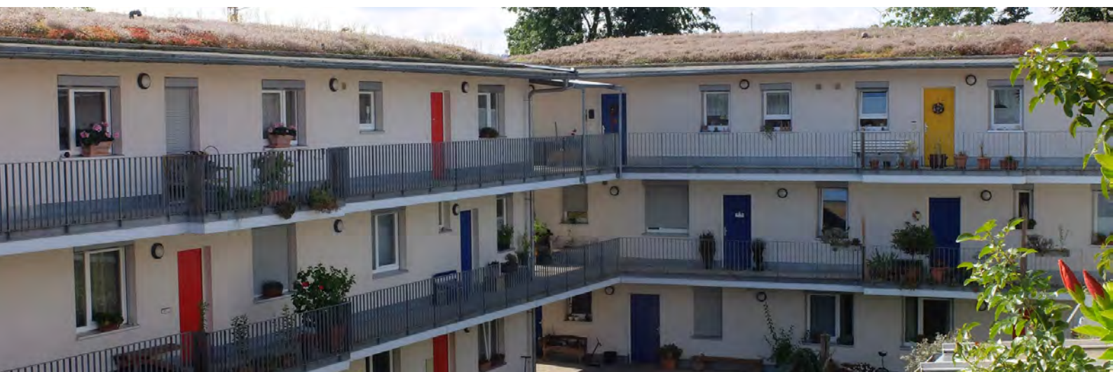
Ansicht der hofseitigen Laubengänge des Wohnprojekts
