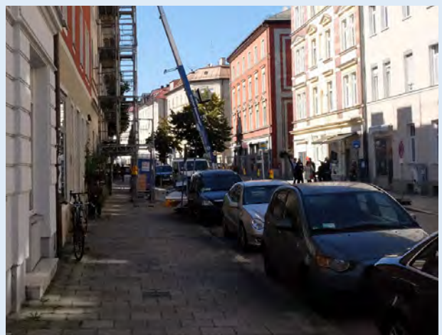
Im Bezirk wird viel saniert.
