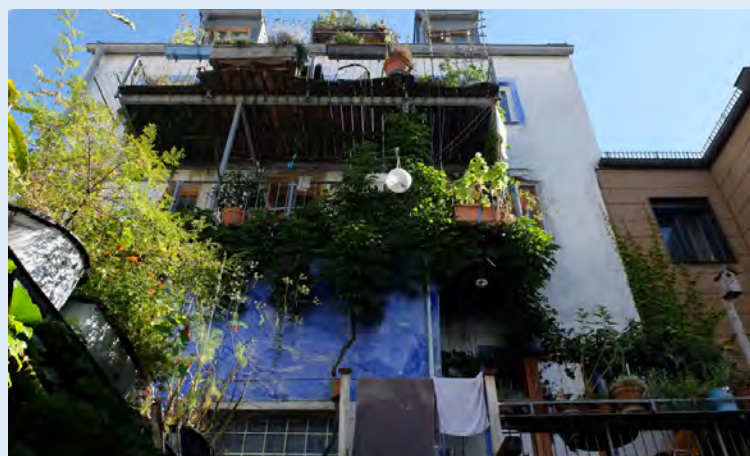
Balkone zum Blockinnenbereich.
